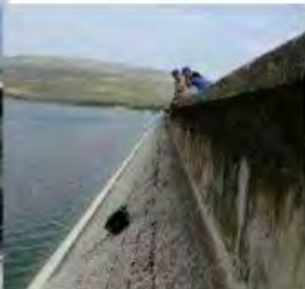
Descente du ROV sur le masque amont
